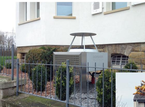
Moderne Luftwärmepumpen sind in der Regel flüsterleise und lassen sich optisch gut integrieren.
