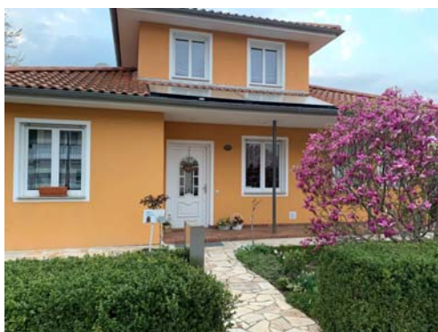
Innovative Heiztechnik in Dresdens Süden: Neueste Invertertechnik in Kombination mit Solarthermie
