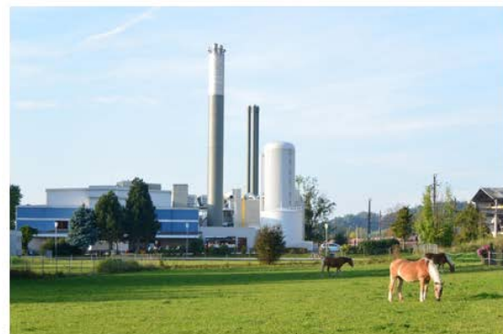
Abbildung 31: Heizwerk in Kirchdorf an der Krems. (Quelle: Energie AG OÖ Wärme GmbH)
