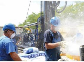
oben: Die Qualität der Ringraumverfüllung kann mit speziellen Sonden bereits während des Verfüllvorgangs überwacht und dokumentiert werden.
