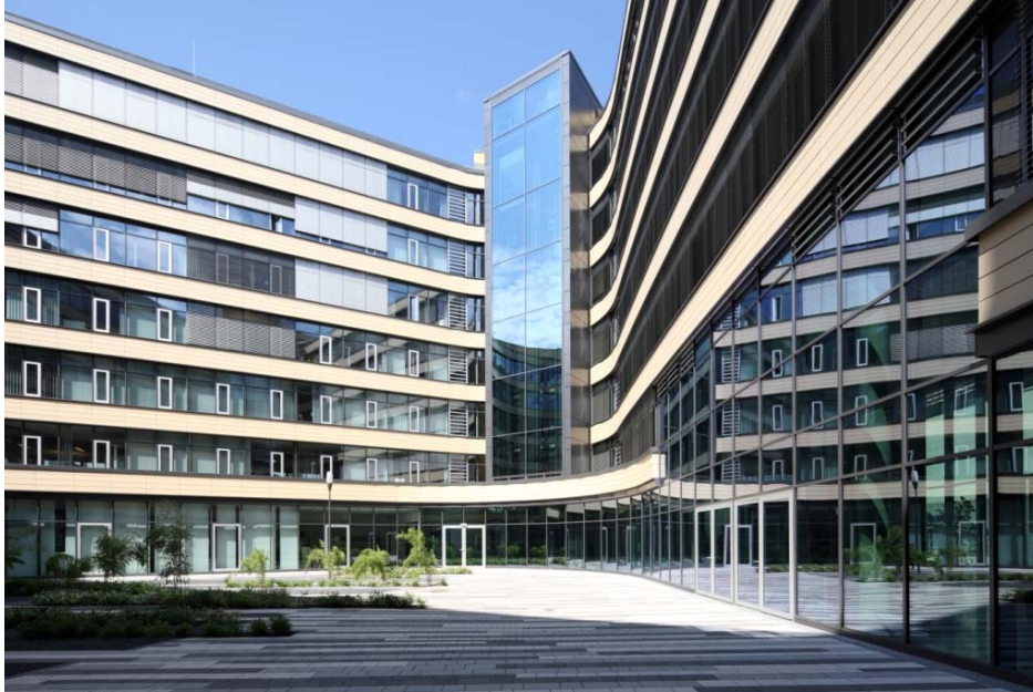
0203_Süwag-Zentrale: Die dreieckige Gebäudeform spiegelt sich auch im Innenhof wieder.
