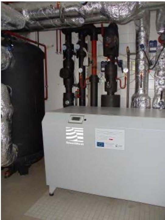
**02\_Sportanlage:** Wärmetauscher und Heizzentrale wurden in einem Container untergebracht, der eigens dafür auf dem Sportgelände installiert wurde. Bevor das aus dem Kanal hochgepumpte Abwasser den Wärmetauscher erreicht, wird es durch ein Sieb geleitet und von Ablagerungen befreit.
