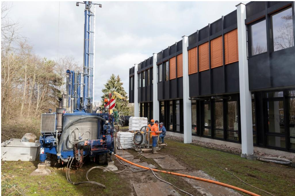
**01\_Weishaupt-Niederlassung Stuttgart:** Die Niederlassung in Stuttgart wird künftig bivalent betrieben. Eine Sole/Wasser-Wärmepumpe heizt und kühlt die Büroräume, die vorhandene Ölheizung ist weiterhin für die Lagerräume zuständig.
