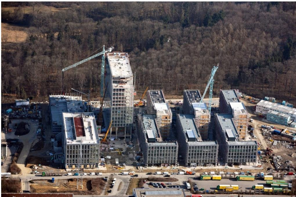
**03\_EnBW City:** Zwei Jahre lang wurde an dem Gebäudeensemble gebaut. Unter ihm befindet sich eine gigantische Erdwärmeanlage: 96 Sonden wurden 130 Meter tief in die Erde gebracht. Damit zählte die Anlage damals zu den größten in Europa.
