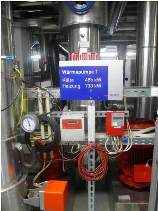
**05\_EnBW City:** Über die Betonkerntemperaturung kann das Gebäude entweder gekühlt oder geheizt werden. Bei der Kühlung laufen die beiden Wärmepumpen von Airwell im reversiblen Betrieb und sparen gegenüber einer herkömmlichen Klimaanlage große Mengen an CO<sub>2</sub> ein.
