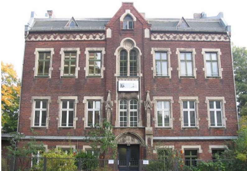
01_Montessori Schule: Das ehemalige Gemeindehaus mit neugotischen Elementen steht unter Denkmalschutz und beherbergt heute die integrative Montessori Grundschule in Berlin-Pankow. (Quelle: BAKA)
