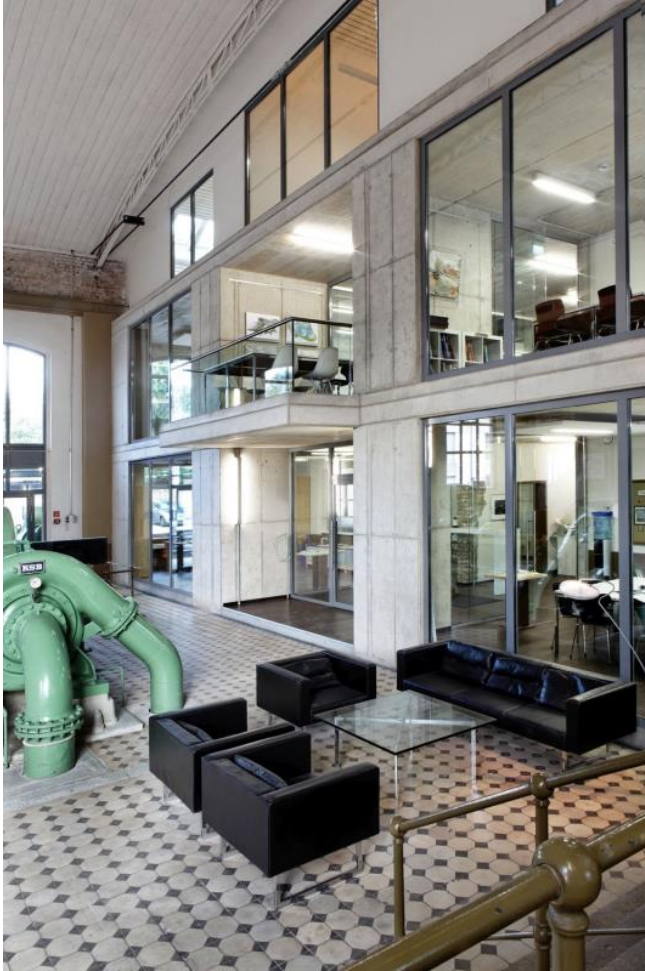
In die alte Pumpenhalle wurde ein neuer Bürotrakt integriert, der mit einer Wärmepumpe mit solarem Eisspeicher geheizt und gekühlt werden kann (Bildquelle: BMFS GmbH & Co. KG).
