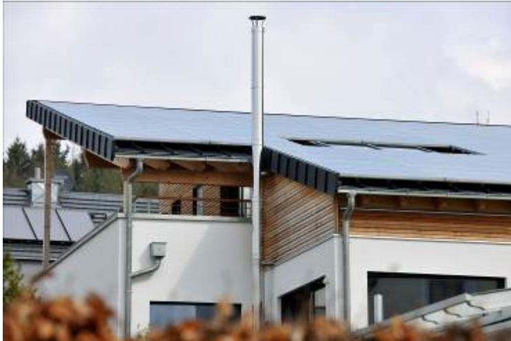
**LEW2:** Das Plusenergiehaus verfügt über eine Photovoltaikanlage sowie über eine Luft/Wasser-Wärmepumpe mit großem Pufferspeicher und einen Lithium-Ionen-Akku, die die auf dem Dach erzeugte Energie speichern können. Was dann noch übrig bleibt, wird ins Netz eingespeist.
